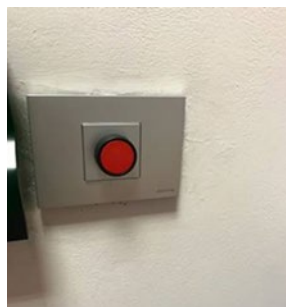
Pulsador: de corte de la señal situado en el exterior de la cabina.
