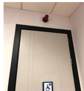
Señal lumínica y sonora situada en zona visible exterior y/o conectada a zona de control.
