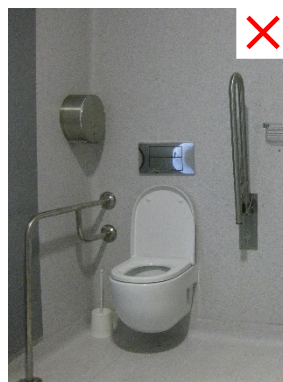
Inodoro suspendido corto. No permite una transferencia segura
