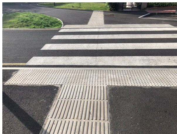
Paso peatonal con pavimentos táctiles
