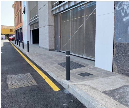
Interfiere en el itinerario peatonal
